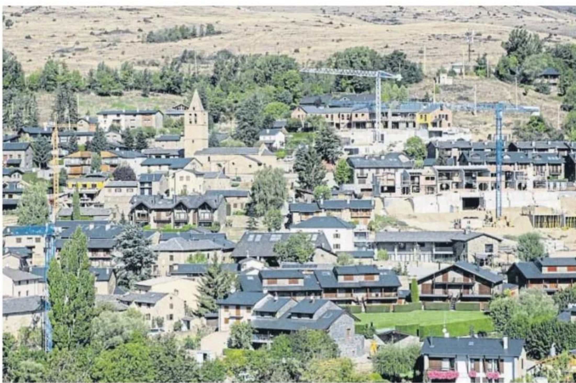
Grúas de casas en construcción en el pueblo de Bolvir, en una imagen tomada en septiembre del 2023
