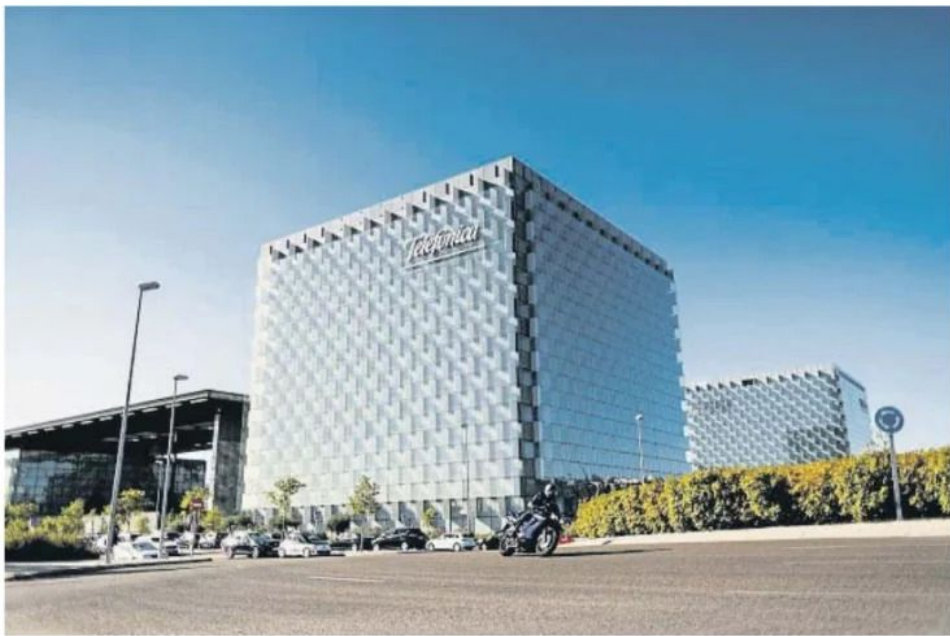
Sede de Telefónica en el barrio de La Tablas (Madrid)
